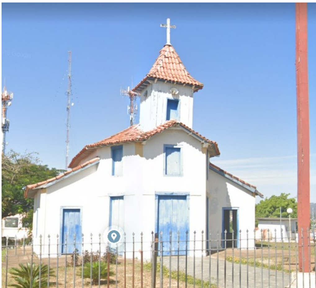
Fachada frontal da Capela de Nosso Senhor do Bonfim Fonte: Google Maps - captura 2019
