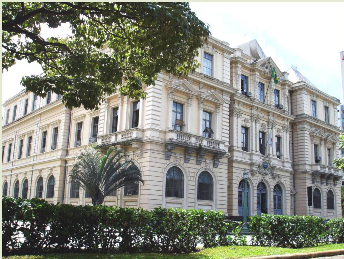
Antigo prédio da Secretaria de Estado da Fazenda, futuras instalações do Memorial Minas Gerais
