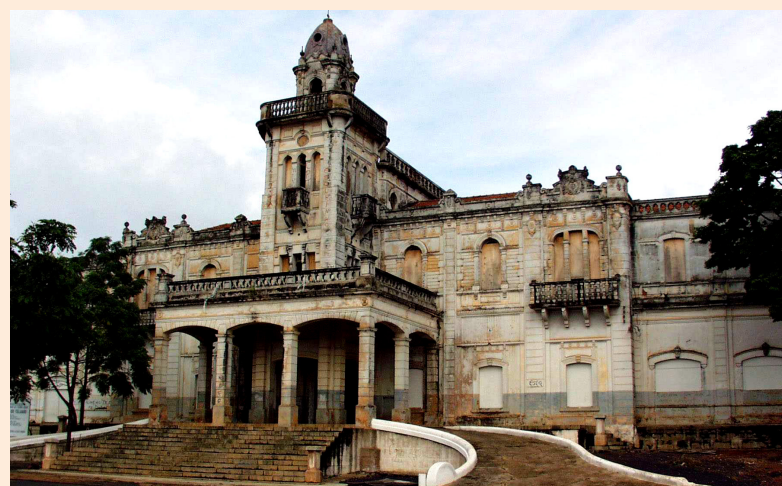
Prédio, totalmente degradado, antes da restauração
