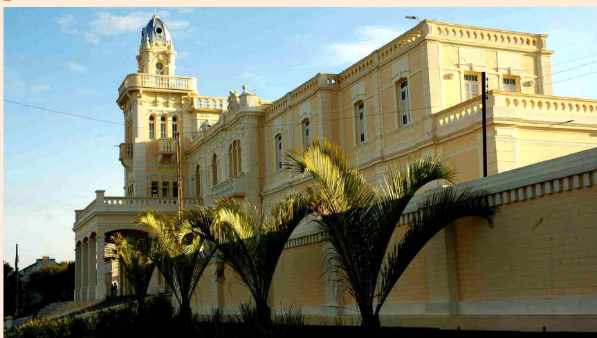
Fachada lateral do prédio recuperado
