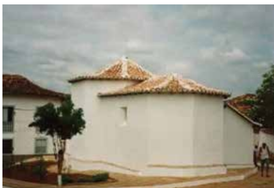
Figura 5: Conclusão dos serviços de pintura a base de cal: Caição Fonte: Acervo IEPHA/MG, s.n.
