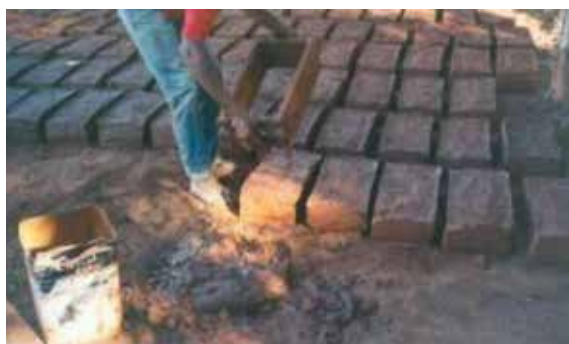
Figura 2: Terra amassada e modelada a mão em moldes de madeira-tijolo de adobe Fonte: Acervo IEPHA/MG, s.n.
