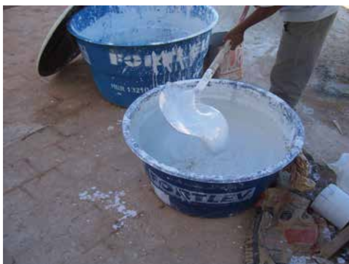
Figura 10: Maturação da cal hidratada Fonte: Acervo IEPHA/MG, s.n.
