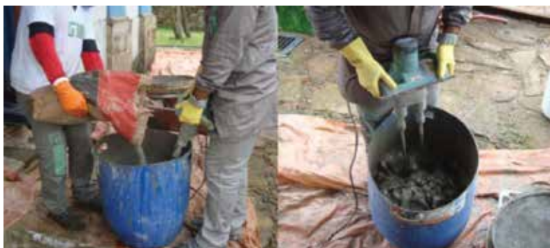
Figura 6: Técnica Contemporânea: mistura e preparo de argamassa de barro Fonte: Acervo IEPHA/MG, s.n.
