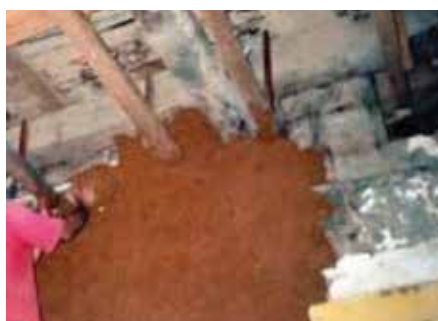
Figura 3: Vedação de barro sobre entreamado de madeira, amarrados com embirra: Parede de pau-a-pique Fonte: Acervo IEPHA/MG, s.n.
