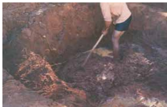
Figura 7: Técnica Tradicional: mistura e preparo de argamassa de barro Fonte: Acervo IEPHA/MG, s.n.
