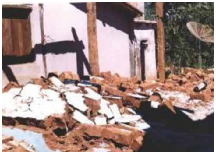
Figura 15: Intervenções desastrosas Fonte: Acervo IEPHA/MG, s.n.
