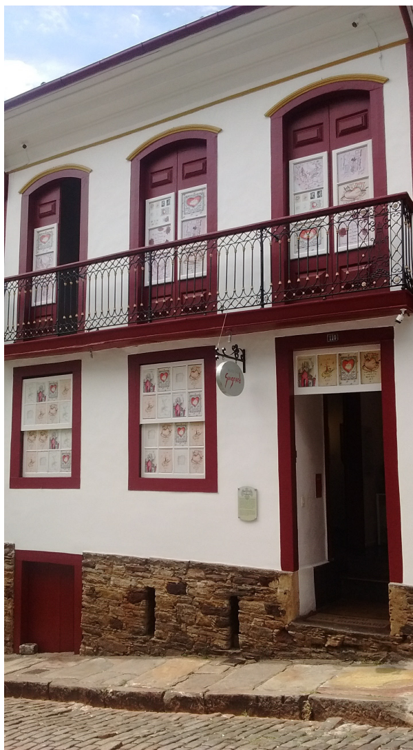
Foto 1 – Museu Casa Guignard - Fachada Frontal – Ouro Preto – MG
