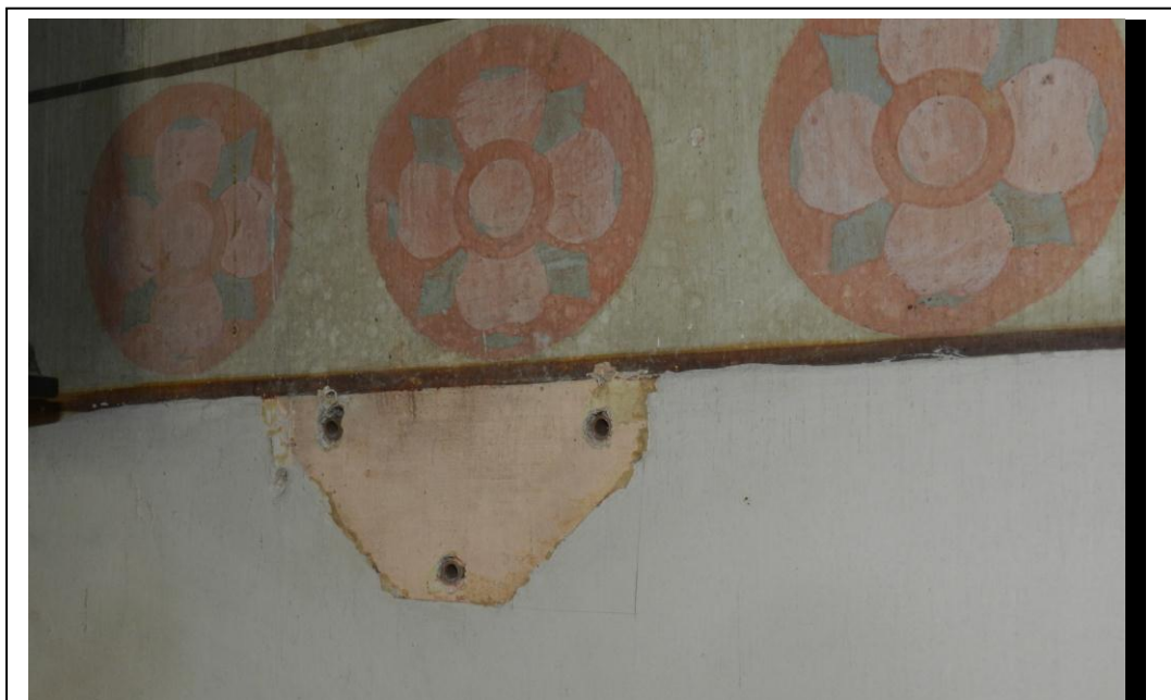
Figura 13: Detalhe da pintura em estêncil, apresentando manchas de umidade e esmaecimento, e pintura lisa apresentando orifícios. Foto: IEPHA, 06-10-2020.
