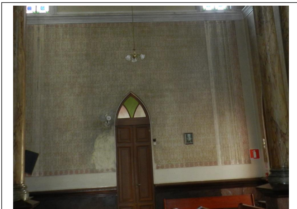
Figura 12: Pintura em estêncil, apresentando manchas escuras e perdas de camada pictórica. Foto: IEPHA, 06-10-2020.
