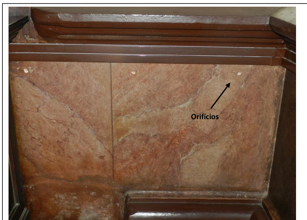
Figura 14: Detalhe do barrado marmorizado, apresentando orifícios e perda do rodapé. Foto: IEPHA, 06-10-2020.
