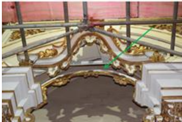
Foto 13: Perda do forro, parte do coroamento e fundo do nicho. Foto 14: Detalhe da perda de parte do coroamento. Fotos: Arquidiocese de Belo Horizonte/jul. 2020
