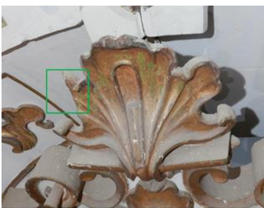
Fotos 15 e 16: Pequenas perdas na talha e galerias de cupins. Fotos: IEPHA/MG, 10/07/2020.
