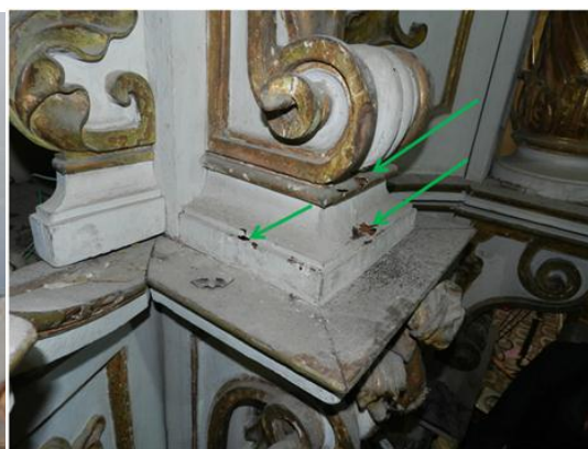
Fotos 15 e 16: Pequenas perdas na talha e galerias de cupins. Fotos: IEPHA/MG, 10/07/2020.
