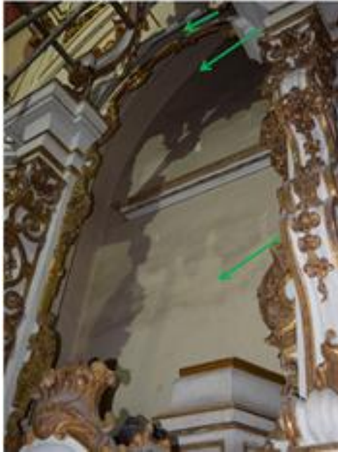
Foto 13: Perda do forro, parte do coroamento e fundo do nicho. Foto 14: Detalhe da perda de parte do coroamento. Fotos: Arquidiocese de Belo Horizonte/jul. 2020
